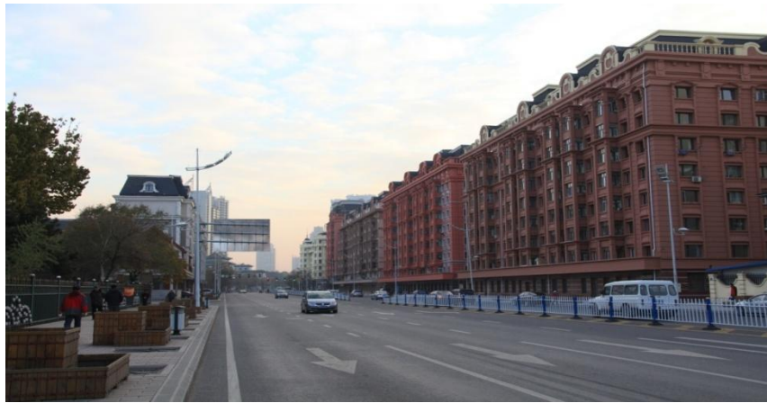
节能改造后建筑外观
