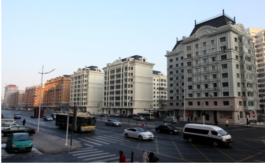
节能改造后建筑外观
